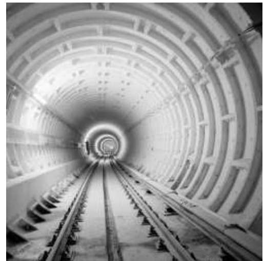
Vue vers l'est de la section nouvellement construite du tunnel du métro TTC, 1968 (Archives de la ville de Toronto).
