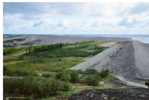
La Grande-1 main dam (Archives d'Hydro-Québec).
