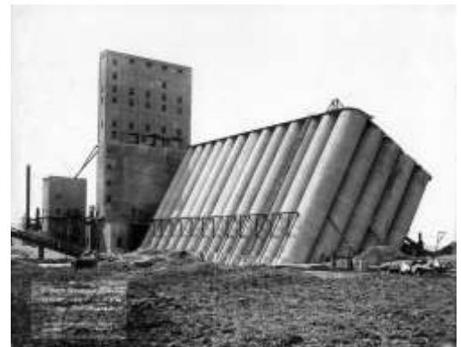
Silos après la défaillance des fondations.
