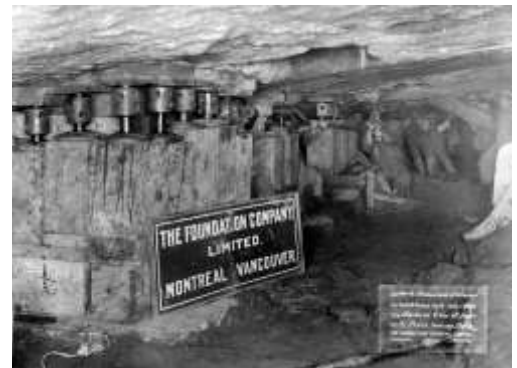
Vis du soutien temporaire pour le redressement de la structure.
