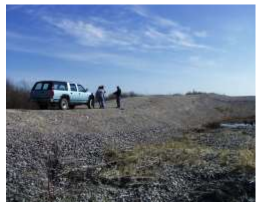
Exemple de tassements différentiels le long d'une digue avant les travaux de réhabilitation.
