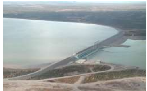
Vue aérienne de la centrale Long Spruce; les digues construites sur le pergélisol discontinu se poursuivent vers le coin supérieur gauche de la photo. Photo: Manitoba Hydro.
