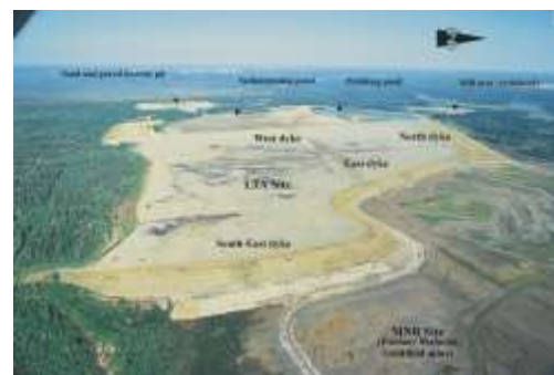
Vue aérienne du parc à résidus miniers LTA avant la construction du recouvrement.
