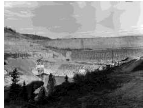
Construction du barrage Kenney, octobre 1952. Photo #00016, Musée Kitimat.
