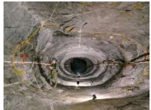
Évaluation de la stabilité de l'excavation rocheuse, où des contraintes différentielles élevées ont été enregistrées.
