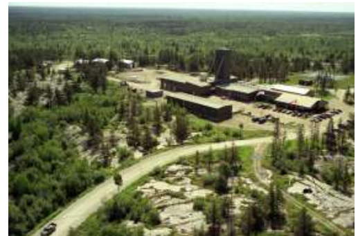
Installations de surface du laboratoire de recherche souterrain (Energie atomique du Canada).
