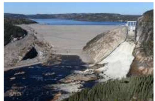
Barrage de la Romaine-2 en opération.
