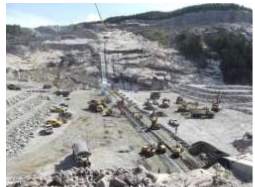
Barrage principal de la Romaine-2 pendant sa construction.
