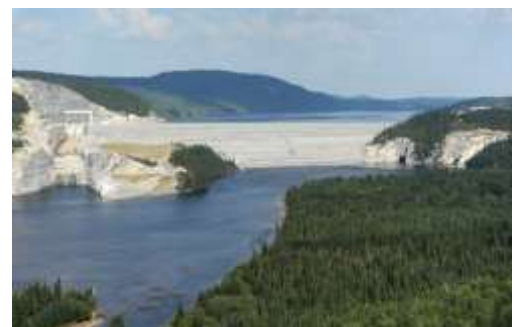
Évacuateur de crues et barrage principal de la Péribonka
