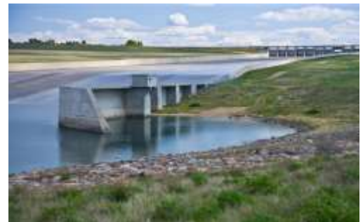
L'évacuateur de crues du barrage Gardiner.
