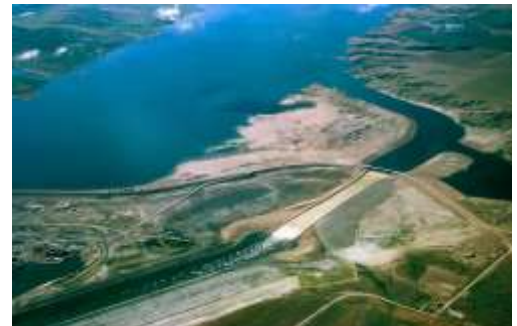
Vue aérienne du barrage Gardiner.
